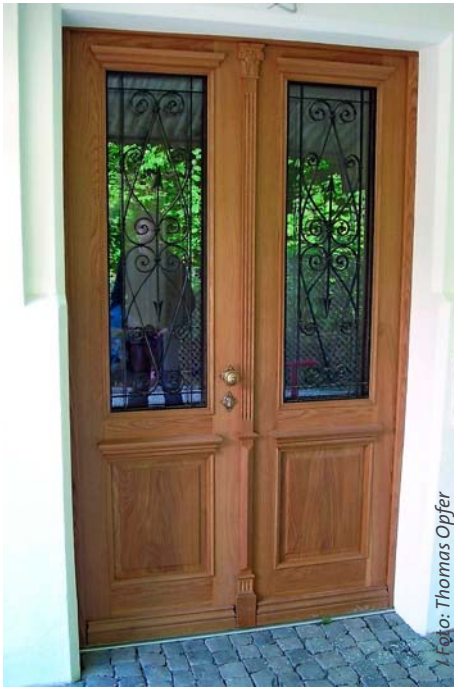
/ Die typischen Merkmale des Historismus sind die Lichtausschnitte mit Ziergitter.
