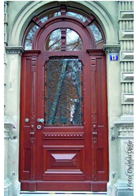
/ Die neue Haustür wurde nach der Stilepoche der Gründerzeit rekonstruiert.
